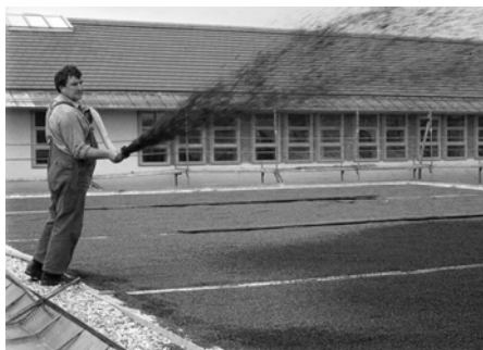
Anspritzbegrünung einer extensiven Dachbegrünung.
