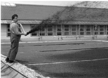
Anspritzbegrünung einer extensiven Dachbegrünung.
